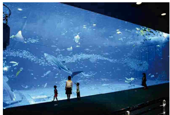
世界最大の亚克力ガラス (幅 22.5m、高さ 8.2m、厚さ 60cm)
