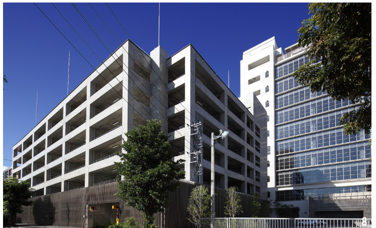
1. 壺川スクエアビル側から見た外観。2. 外観。右隣は壺川スクエアビル。3. 国道からのアプローチ。左手は壺川スクエアビル、右手は同一プロジェクトのホテル棟。4. 壺川スクエアビルへのサブアプローチ。左手がパーキング棟。5. EVホール(基準階)。6. 駐車場(基準階)。7. 駐輪場(1階)。8. 那覇市道側の外観。後方は壺川スクエアビル。 写真提供：株式会社ミヤガワ
