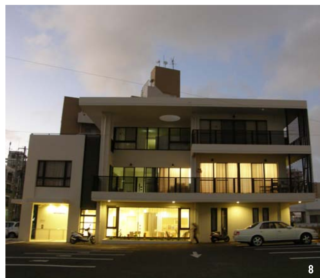
1. 全景。2. 屋根開口部見上げ。 3. エレベーターホール。 4. エントランスホール。 5. 書庫。6. 研修室。7. 閲覧・ 聴読コーナー。8. ファサード(駐 車場側)。
