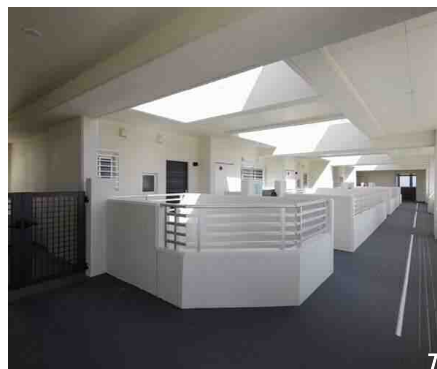
1. 北西側外観。2. 南側外観（夜景）。3. アプローチ。4. エントランスホール。5. 和室。6. リビング。7. アルコーブ・廊下。
