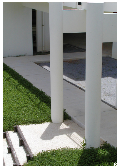
1. セミナー棟。2. テラスからの眺望。3. 食堂。4. セミナー棟。5. 食堂窓。6. 渡り廊下。
