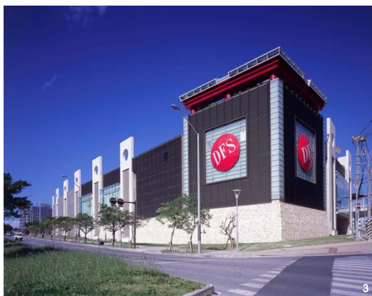
1. 西側外観。2. 交通広場からの外観。3. 南側外観。
